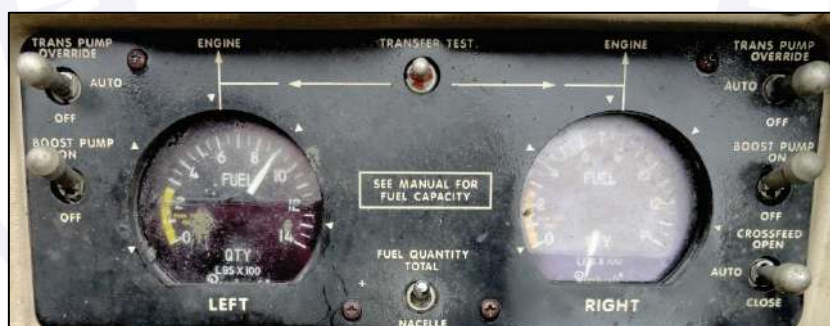
Figura 35 - Painel de controle de combustível
