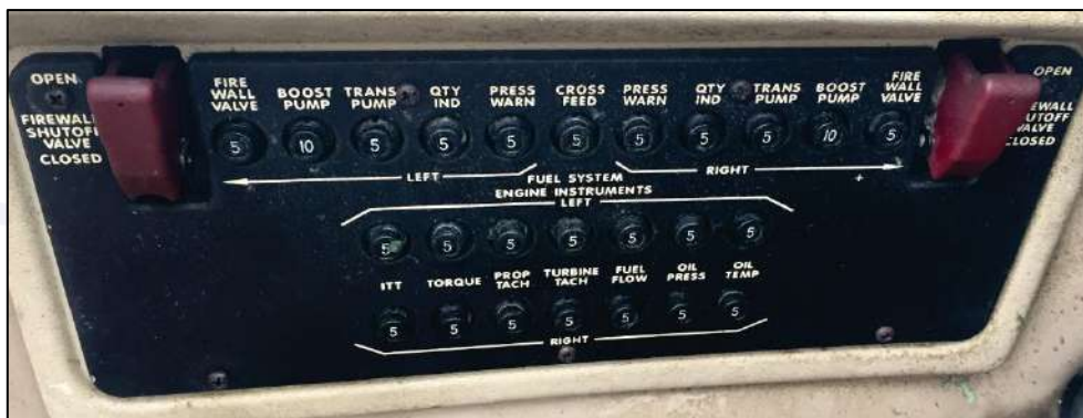
Figura 34 - Painel de disjuntores esquerdo.
